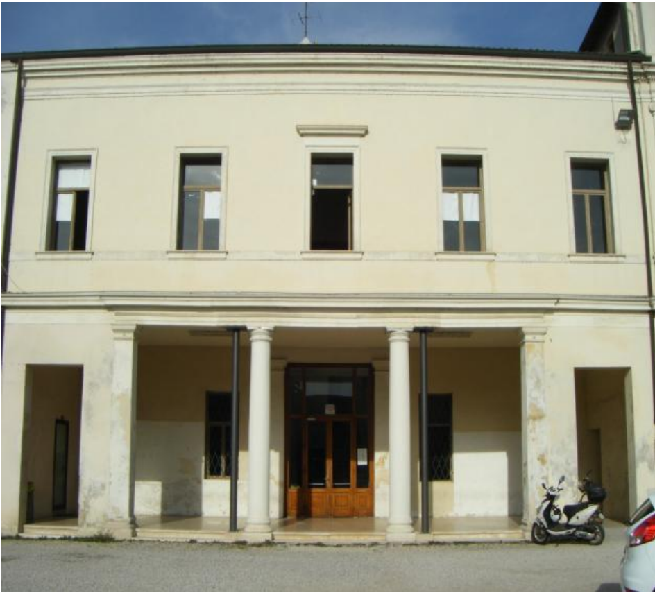
FOTO 10: FACCIATA A SUD - OVEST
