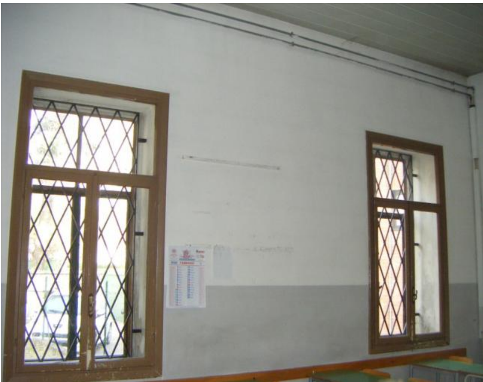
FOTO 9: AULA PIANO TERRA A OVEST
