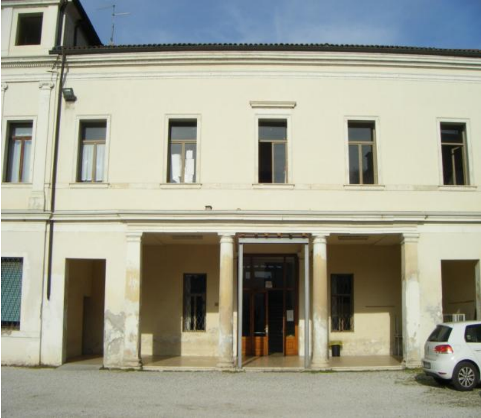
FOTO 11: FACCIATA A SUD - EST
