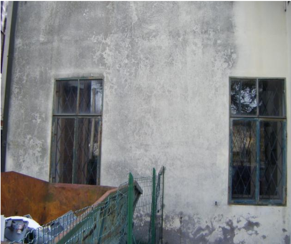
FOTO 15: PARTICOLARE FACCIATA A NORD
