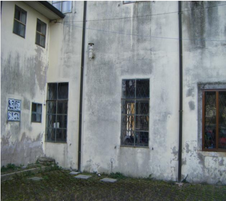
FOTO 14: PARTICOLARE FACCIATA A NORD
