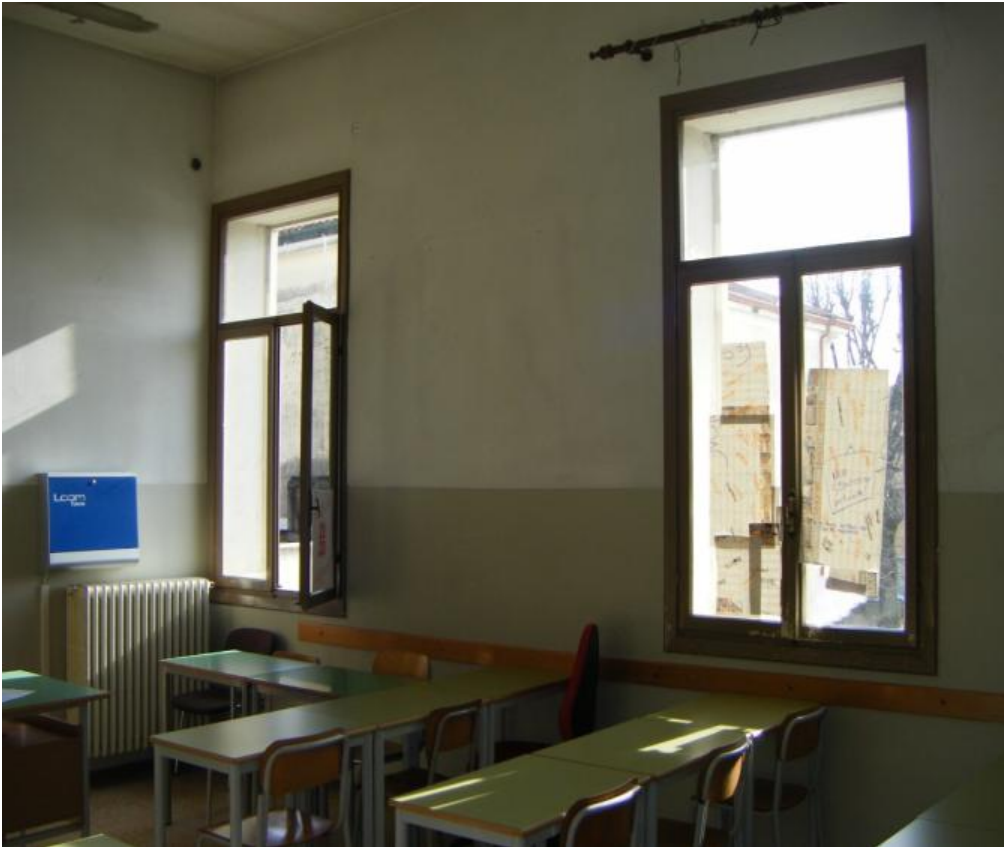
FOTO 1: AULA PRIMO PIANO A EST
